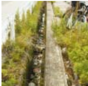
八丁目の側溝
